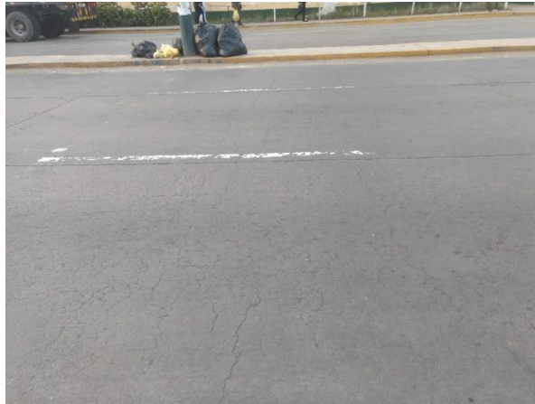
Figura 12. Grietas lineales
