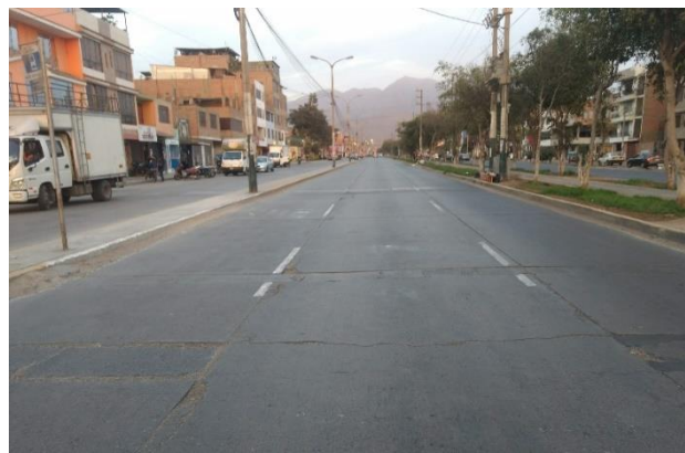
Figura 11. Losa dividida
