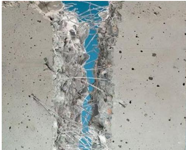
Figura 4: Concreto reciclado con fibras de acero.
