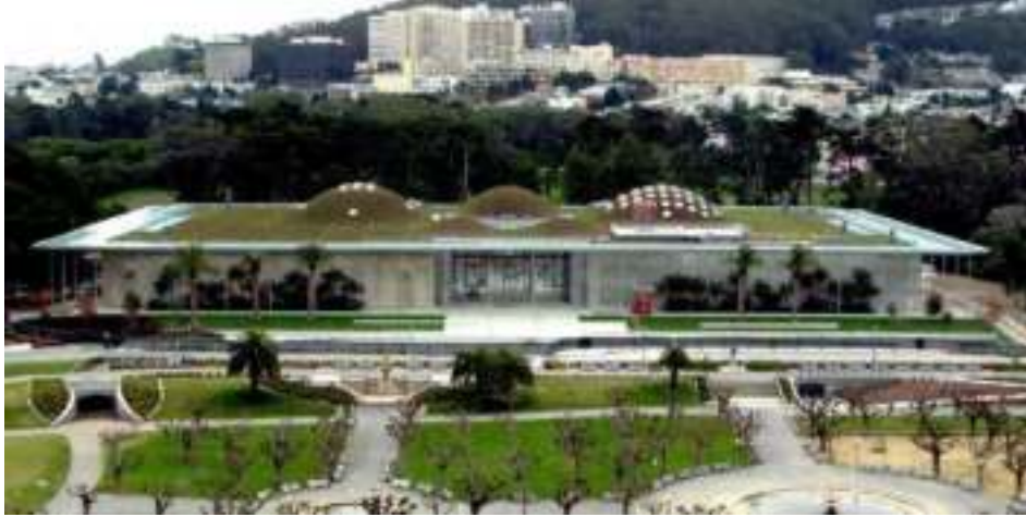
Figura N° 69: Academia de las Ciencias de California- Exterior. Fuente:
