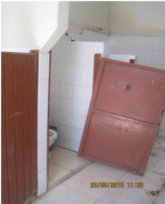
SSHH con puertas caídas, sin agua y con registro abierto
