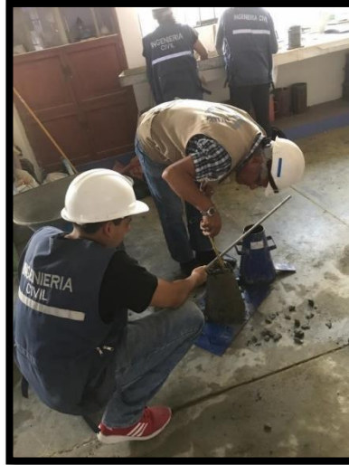
FOTO N° 15 : Ensayo del Slump del Concreto.
