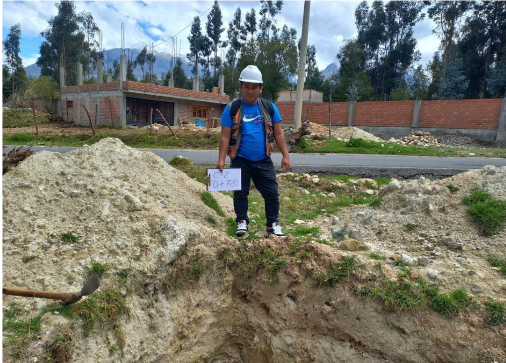
En el proceso de realización de la calicata 3
