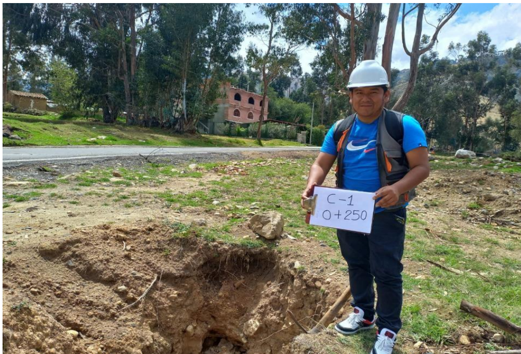
En el proceso de realización de las calicatas 1 y 2
