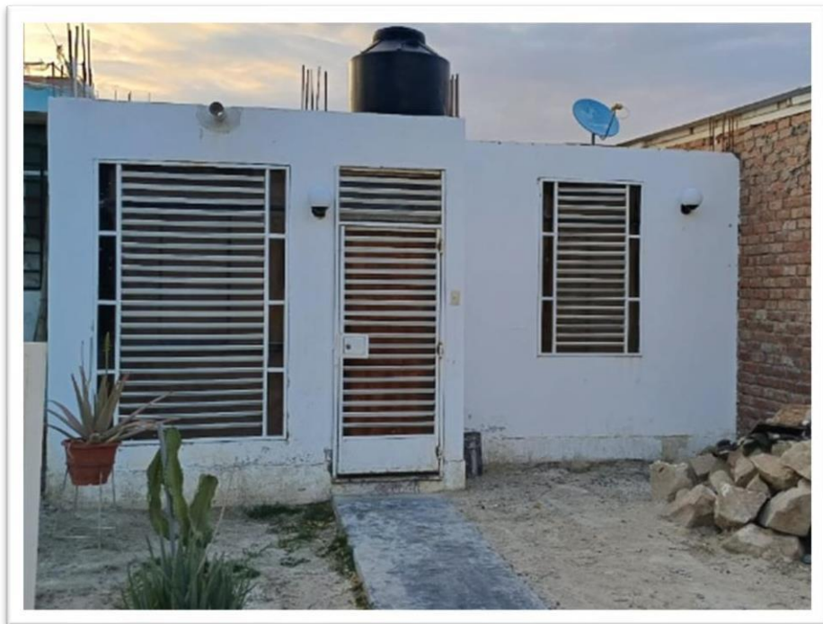
Fachada de vivienda con cemento pulido y puertas metálicas
