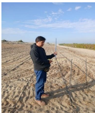
Figura 1. Instalación de riego tecnificado
