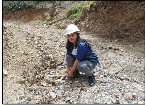
Foto 02: medición de la falla erosión según el método del MTC, generado por ineficiente drenaje.
