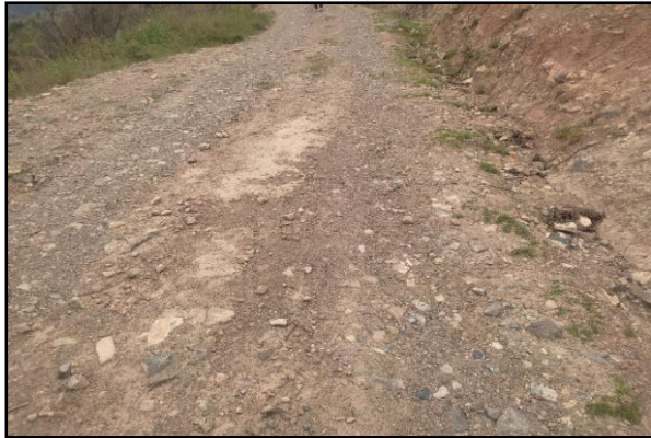
Foto 03: falla de deformación en la vía, según el método MTC. transversal ineficiente, según el método URCI.
