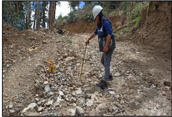
Foto 03: falla de deformación en la vía, según el método MTC. transversal ineficiente, según el método URCI.
