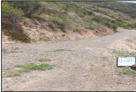
Foto 13: mediciones de encalaminado y borde de la carretera y kilometraje 00+700 de la kilometraje 00+600 en la vía. carretera Amashca – Turuk punta.
