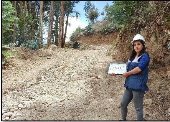
Foto 01: inicio de la carretera Amashca _ Turuk punta (km 00+000).
