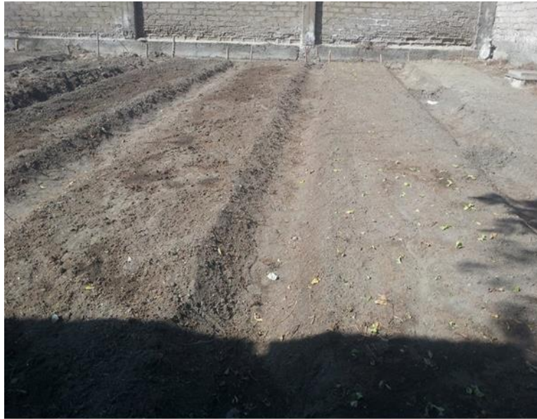
Foto 01: Preparación del suelo en un área de desmonte.
