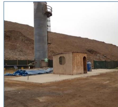
Losa para equipos de la Estación de Compresión
