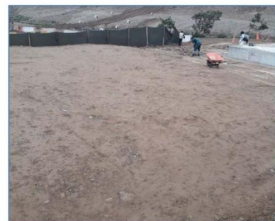
Terreno para Bases de Transformadores
