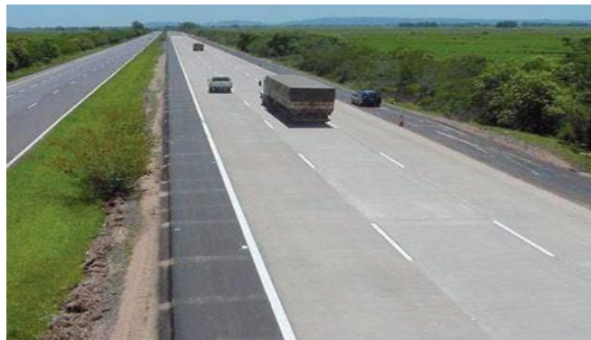
Figura 5. Superficie de Pavimento de Concreto Rígido
