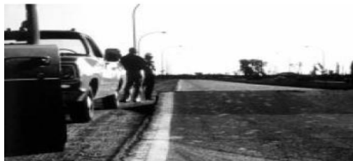
Figura 10. Levantamientos pavimentos rígidos de alta severidad.
