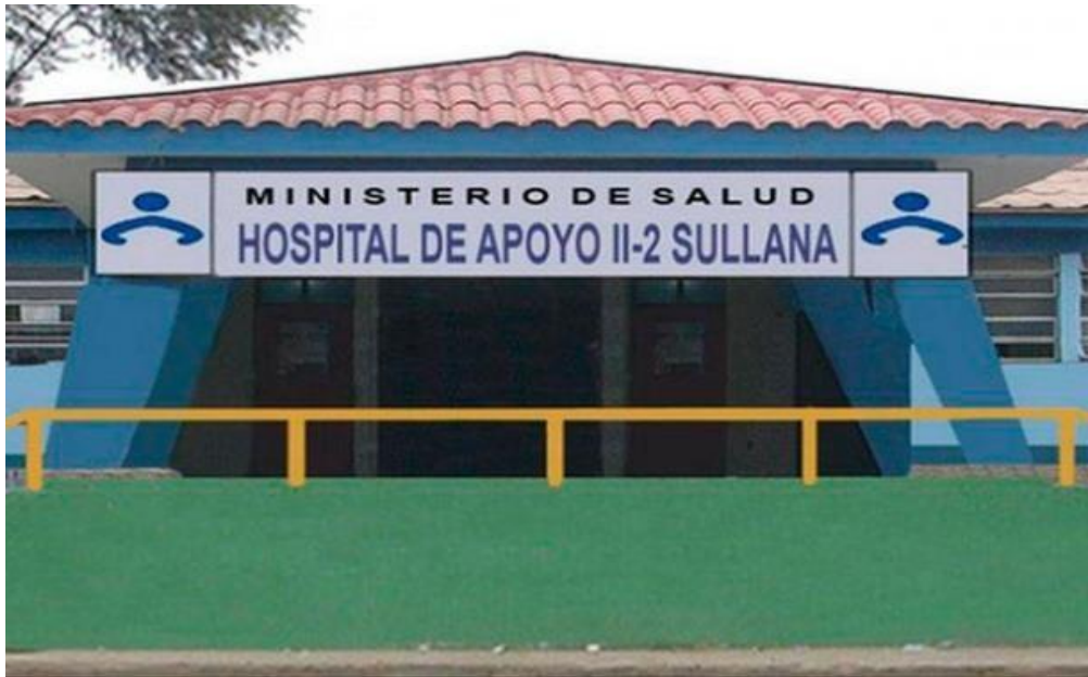
Foto N° 02: Frontis del Hospital de Apoyo II-2 de Sullana
