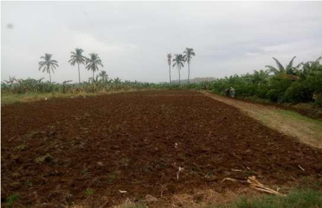
Figura 01: Preparación del terreno (Gradeo)
