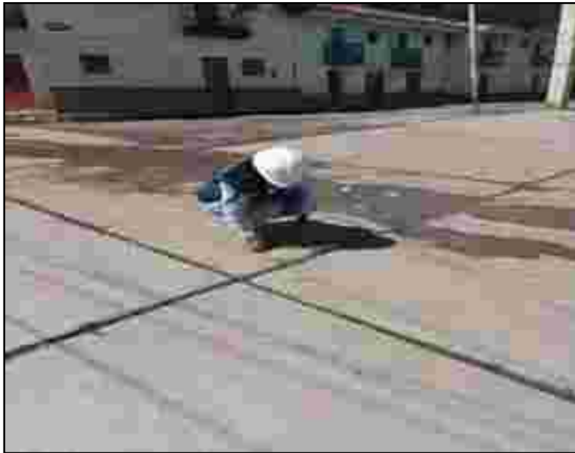
Fotografía 21. Presencia de grietas y descascamiento en juntas transversales.
