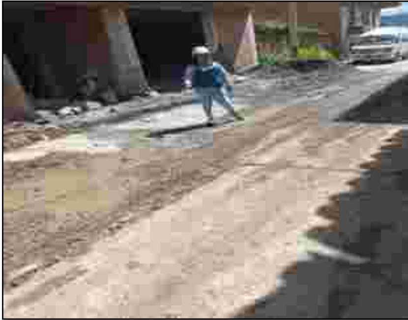
Fotografía 5. Se observa el desprendimiento total de la losa, y presencia de lodo
