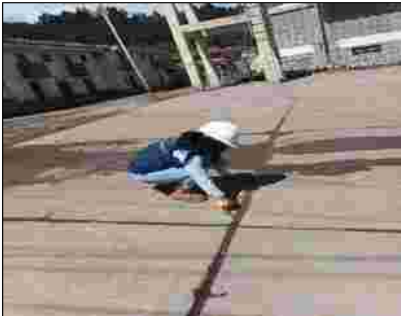
Fotografía 21. Presencia de grietas y descascamiento en juntas transversales.
