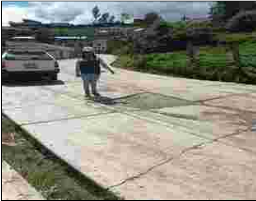
Fotografía 3. Se observa grietas sobre una losa y asentamiento de la misma.
