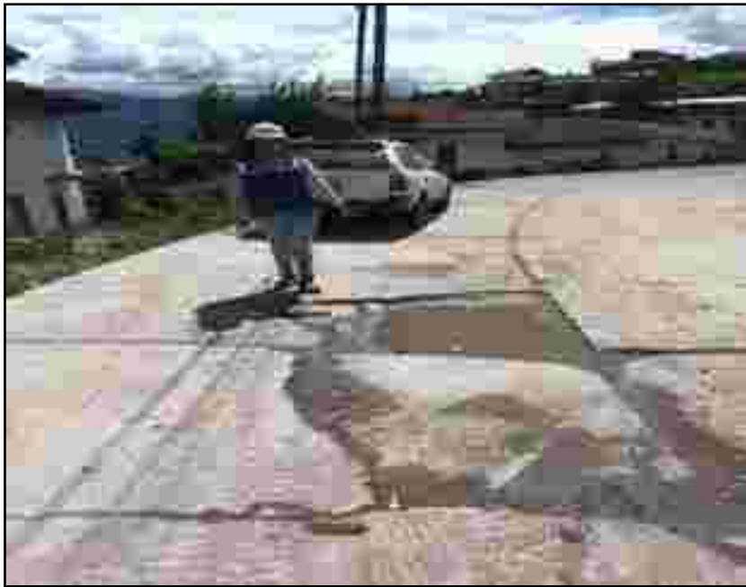
Fotografía 3. Se observa grietas sobre una losa y asentamiento de la misma.
