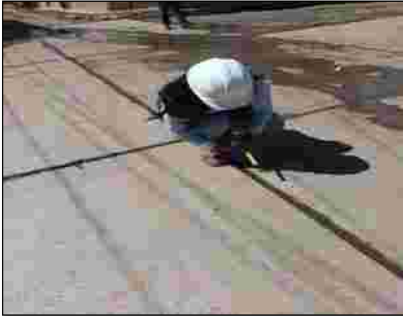
Fotografía 19. Descascaramiento en juntas longitudinales.
