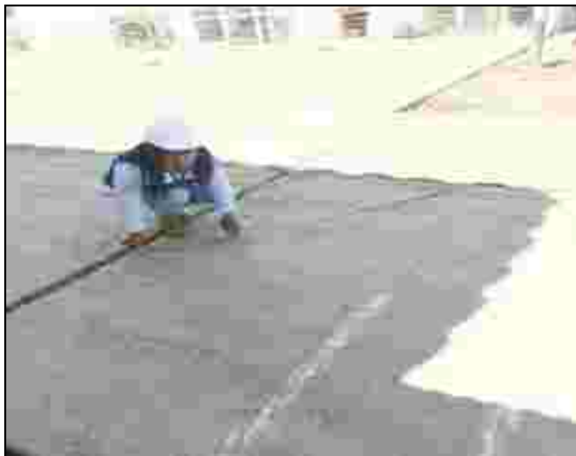
Fotografía 9. se observa pulimiento de agregado en el Jr. Garcilazo de la Vega.
