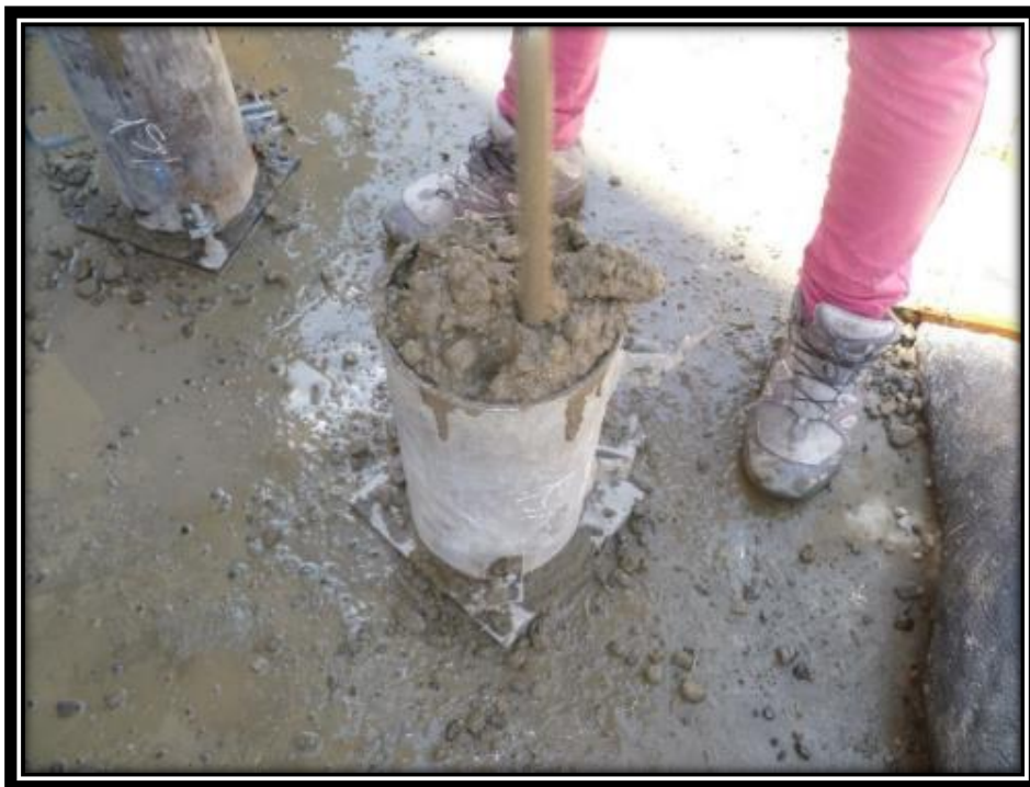
Fotografía N° 06: Llenado de cilindros y compactación varilla de acero.
