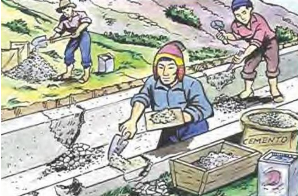
Figura 12: Reforzamiento y reparación del canal de conducción
