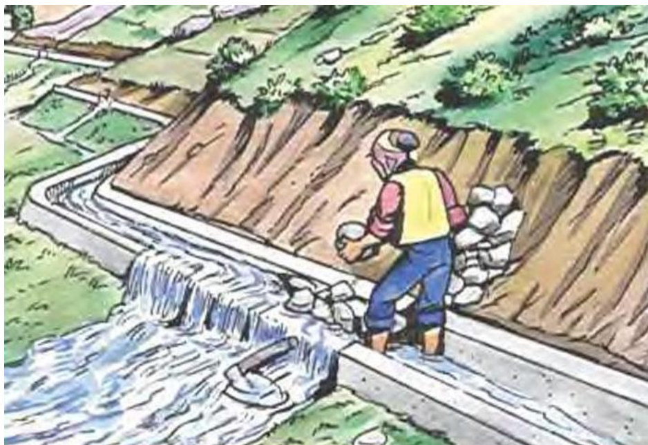
Figura 9: Limpieza de la colmatación de piedras Fuente: Manual N° 3, mantenimiento de infraestructura de sistema de riego; DGIAR, 2015
