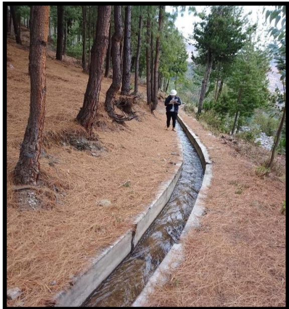
Anexo 04: Arrastre de vegetación seca por causa del desbroce del árbol de pino.
