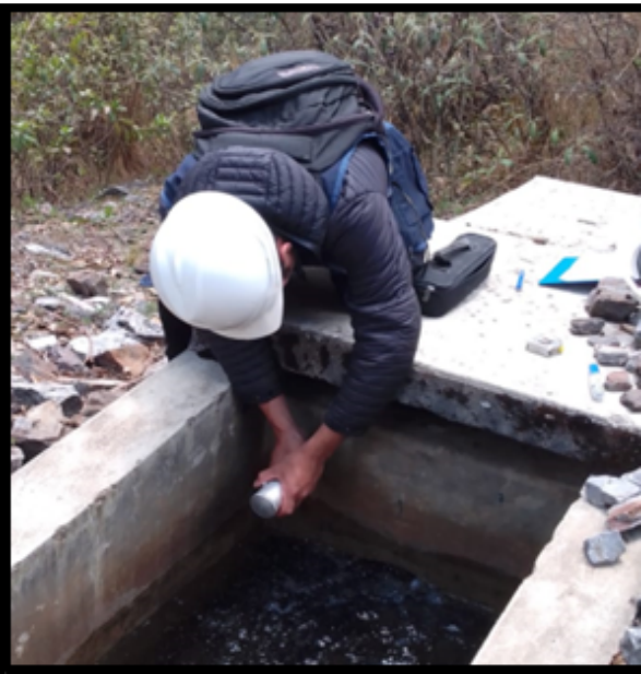
Anexo 03: Tramo 00+757.47 Km, ensayo de la esclerometria en la caja de amortiguacion por golpe.
