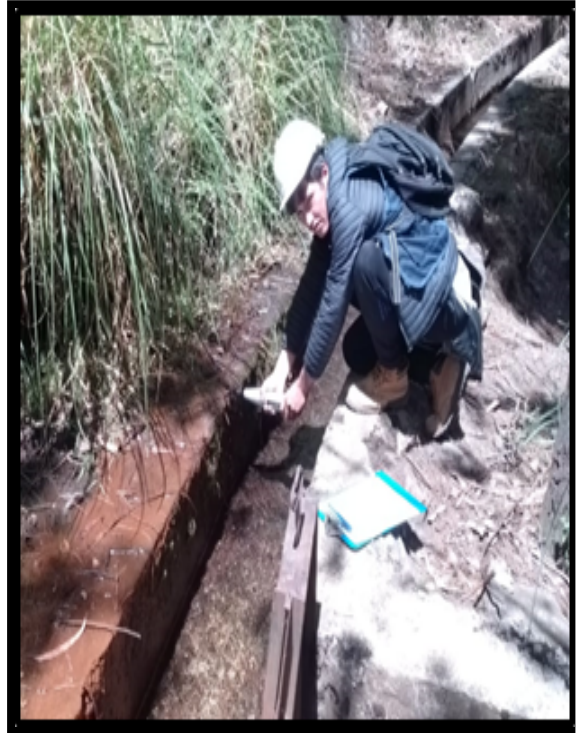
Anexo 02: Empleo del ensayo de la esclerometria en el canal de conduccion.
