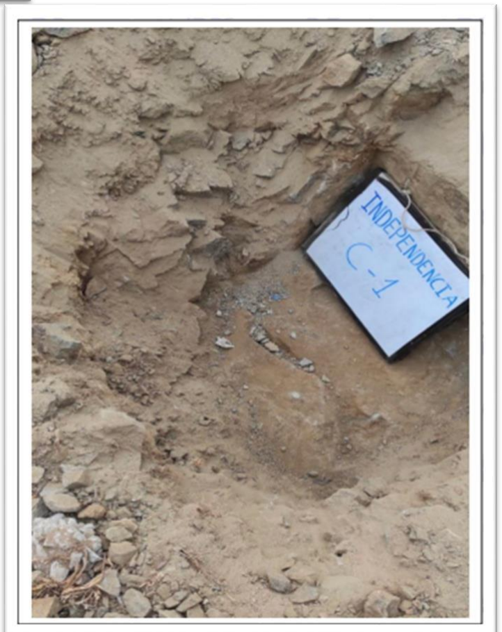
Foto N°02: Vista de la calicata C-01, presencia de roca a 0.65m. de profundidad.
