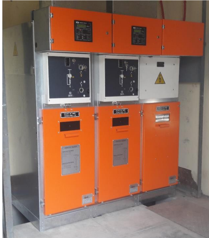
Figura 6 Celda de llegada, protección y salida. Fuente: Instituto de Investigación Tecnológica Agroindustrial
