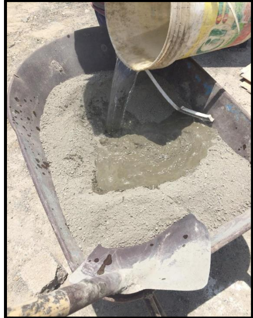
Figura 25. La elaboración de la mezcla para los ladrillos fue manual
