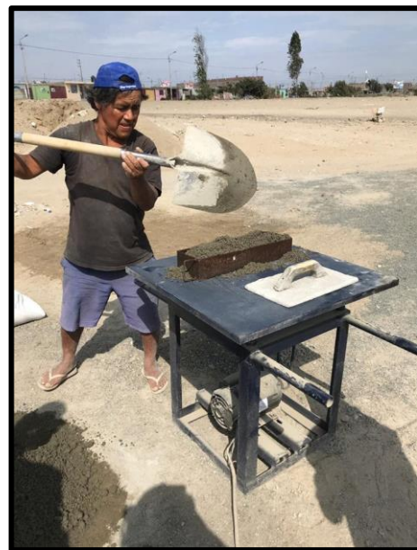
Figura 27. Elaboración de las unidades de albañilería
