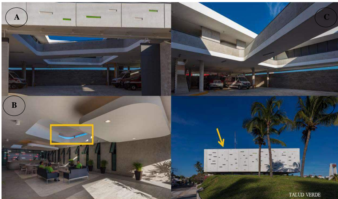
Figura 25. Imágenes interiores de la estación de bomberos Boca del Rio.
