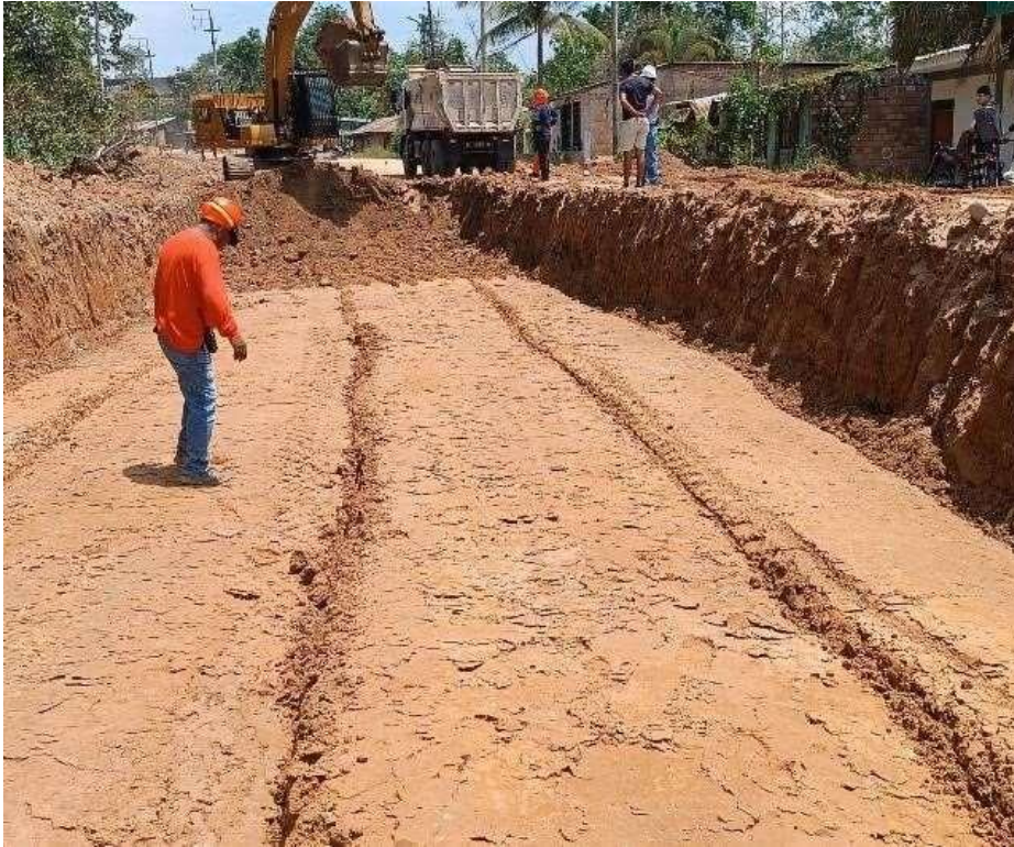
Anexo 10. Mejoramiento a 0.70m por debajo del nivel de subrasante
