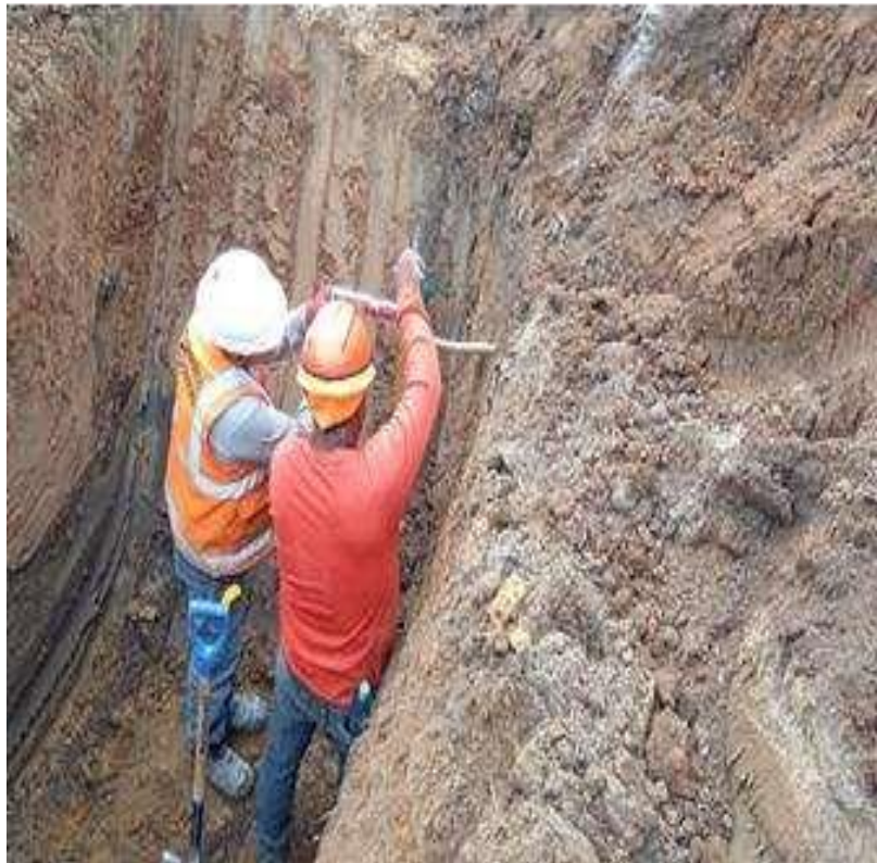
Anexo 7. Verificando la excavación hasta la profundidad propuesta
