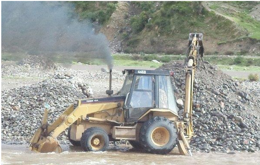
FOTO N° 2: La maquinaria que usan para la extracción del material.
