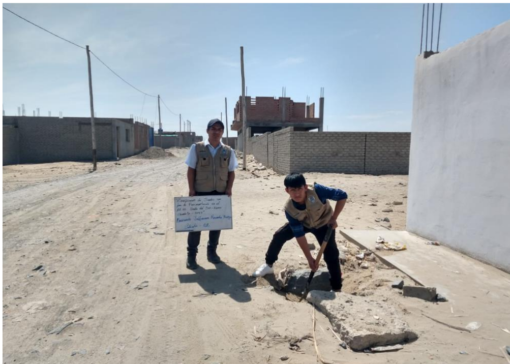
Figura 01. Excavación calicata 1
