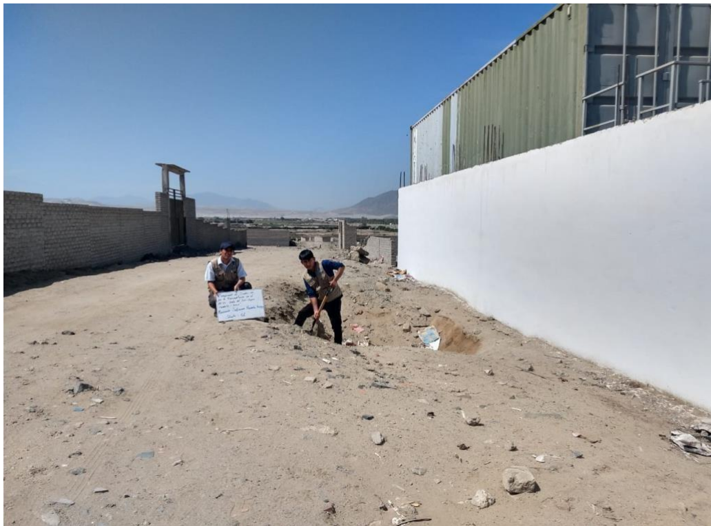
Figura 04. Excavación calicata 2
