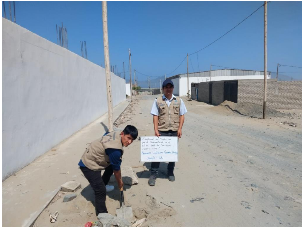
Figura 03. Excavación calicata 2
