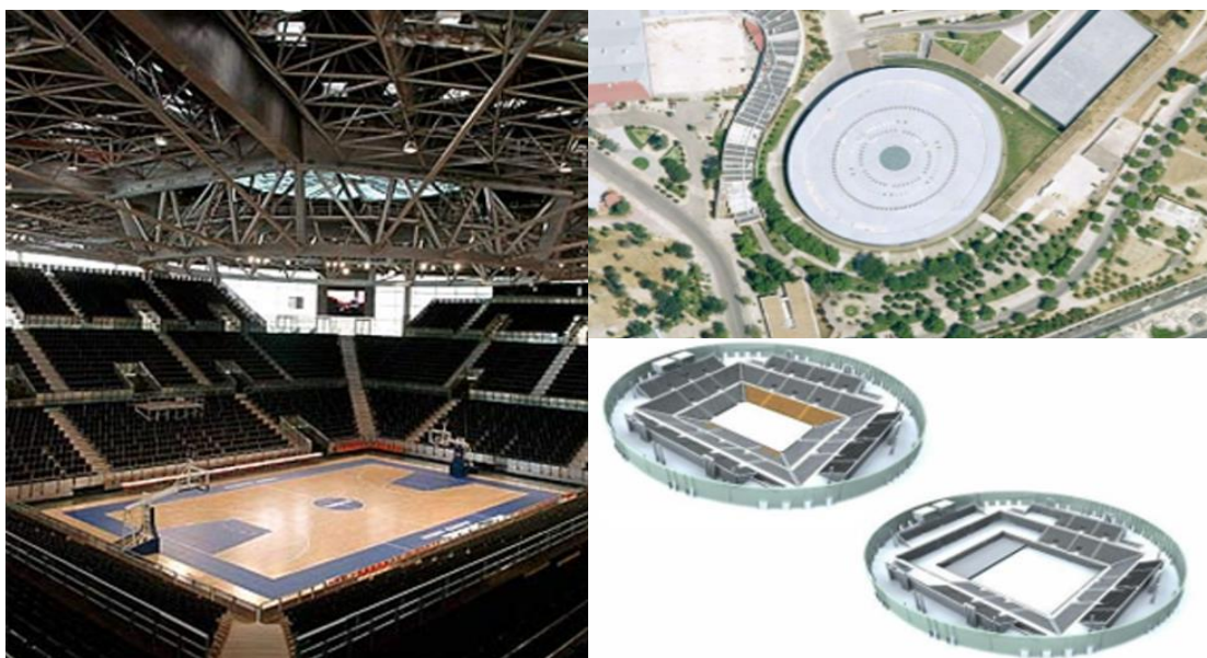
Figura 25. Vista de la geometría y espacios del Coliseo Telefónica Arena Madrid. Fuente: Google.
