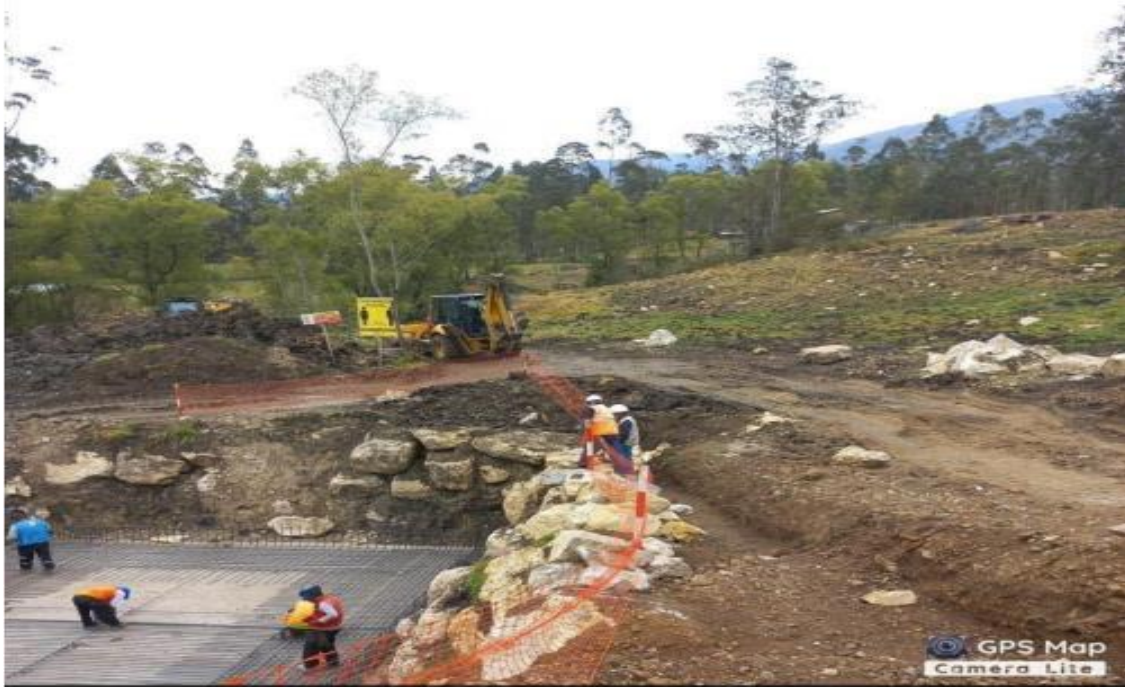
Figura N° 23: Señalización del área de trabajo
