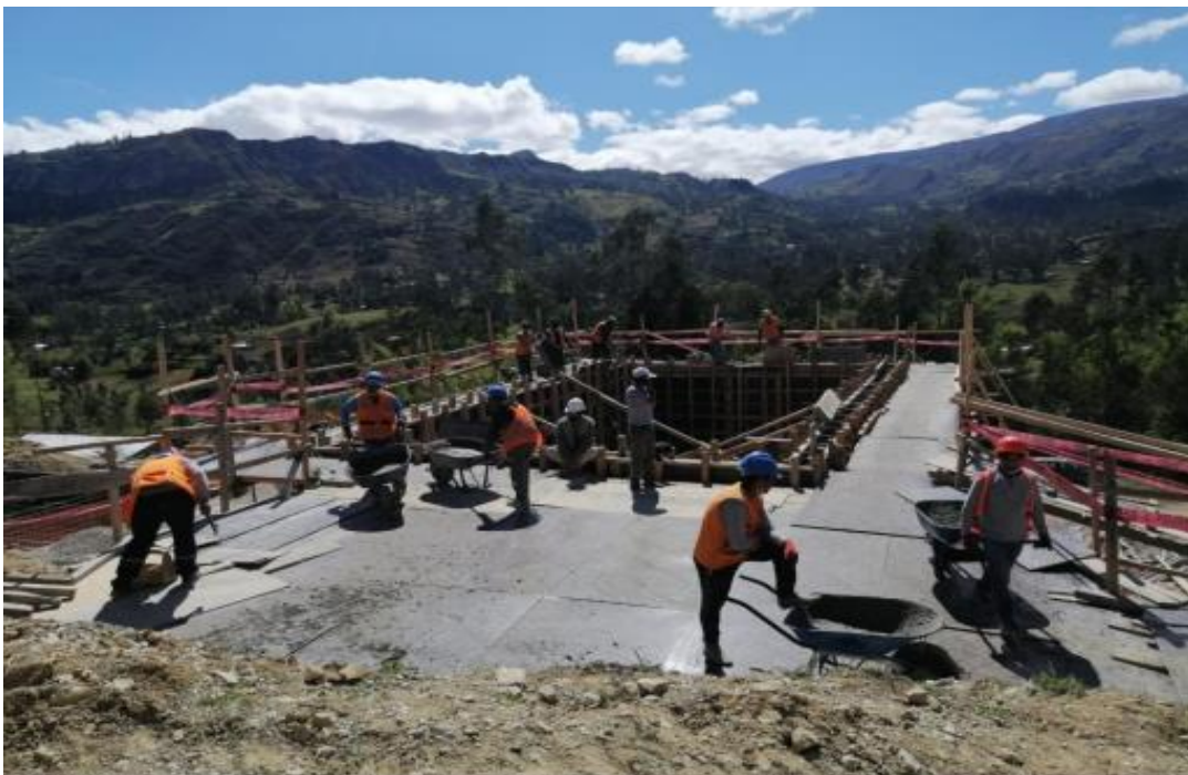
Figura N° 25: Instalación de plataformas con barandas
