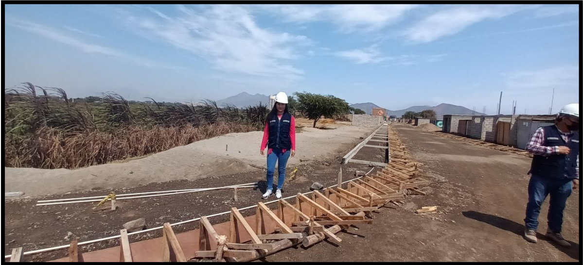
Imagen 07: Colocación del encofrado en las veredas
