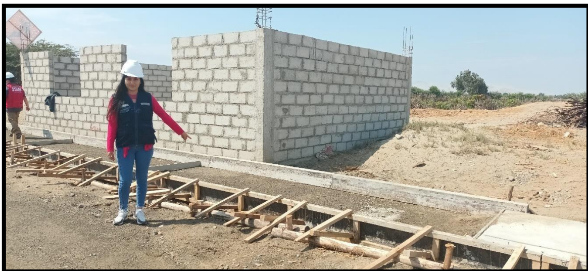
06: Colocación de afirmado en la vereda
