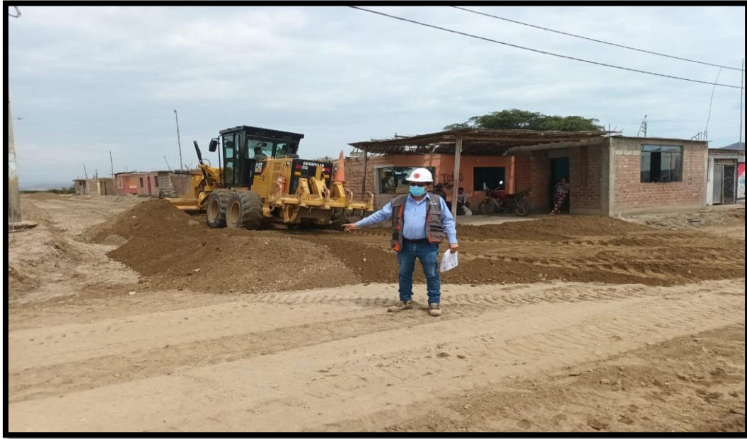
Imagen 04: Colocación del afirmado
