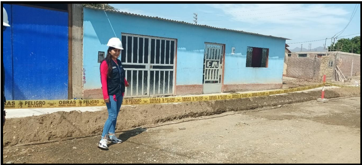
Imagen 07: Colocación del encofrado en las veredas
