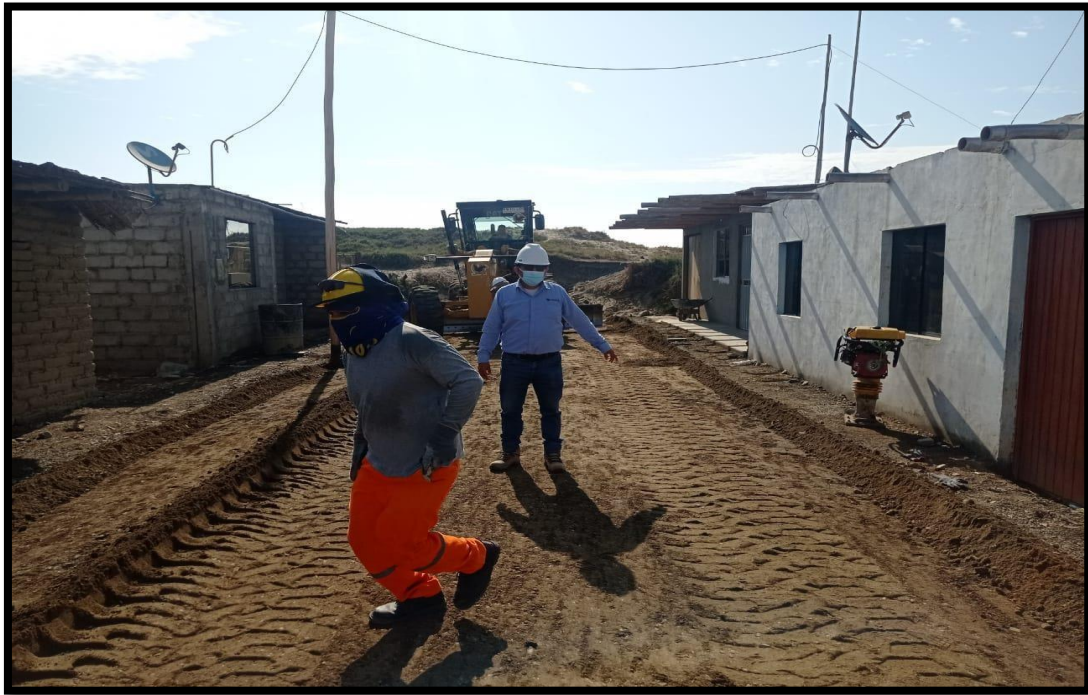
Imagen 10: Colocación de afirmado
