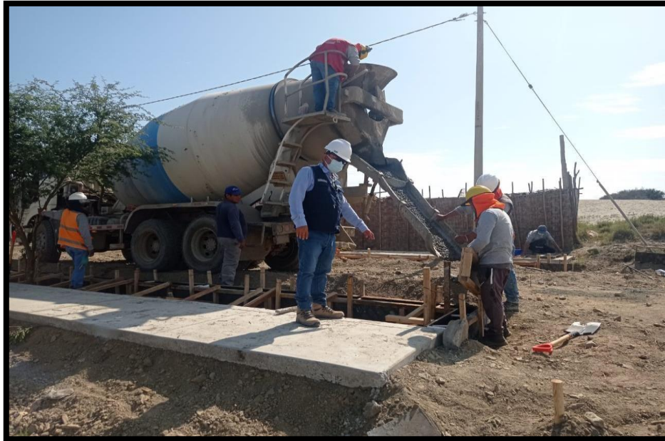
Imagen 12: encofrado y vaciado de sardinel
