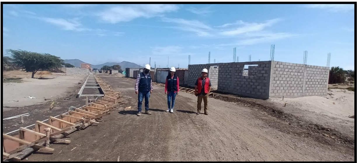
Imagen 09: verificación de la realización de los encofrados
