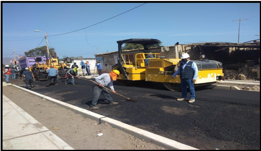
Imagen 11: verificación de los trabajos de la colocación de carpeta asfáltica
