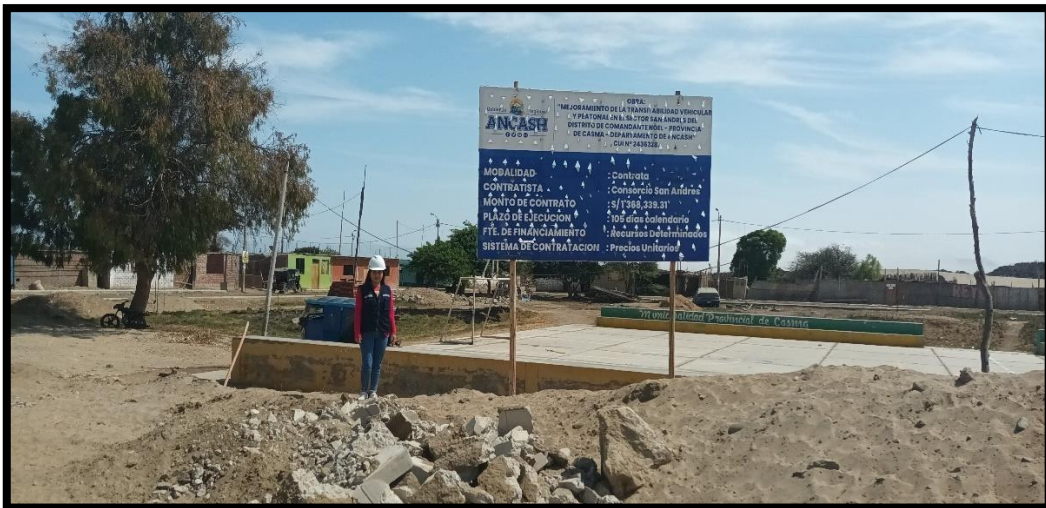
Imagen 01: Colocación de cartel de obra
