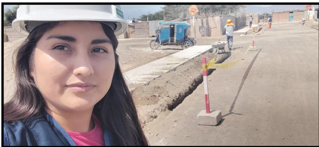
Imagen 03: Excavación de Sardinel Peraltado
