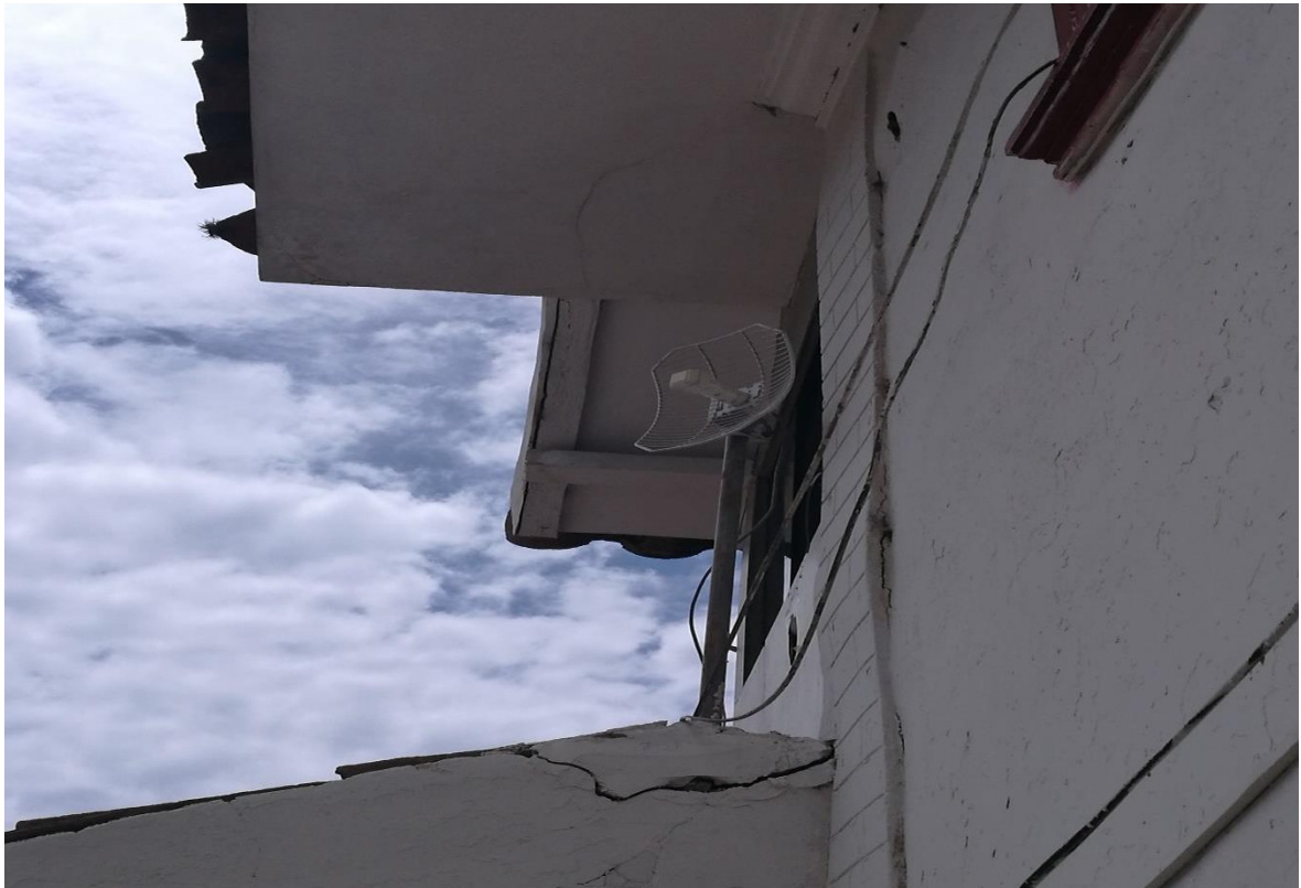
Antena de enlace al local 02
