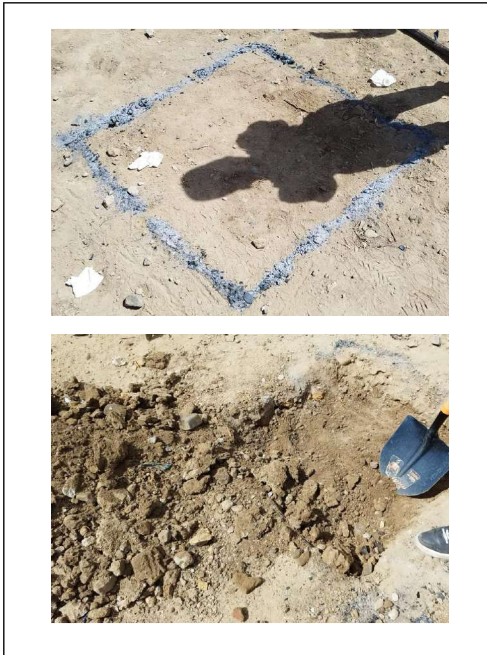
Figura 78. Fotografías del proceso de excavación de calicata.
