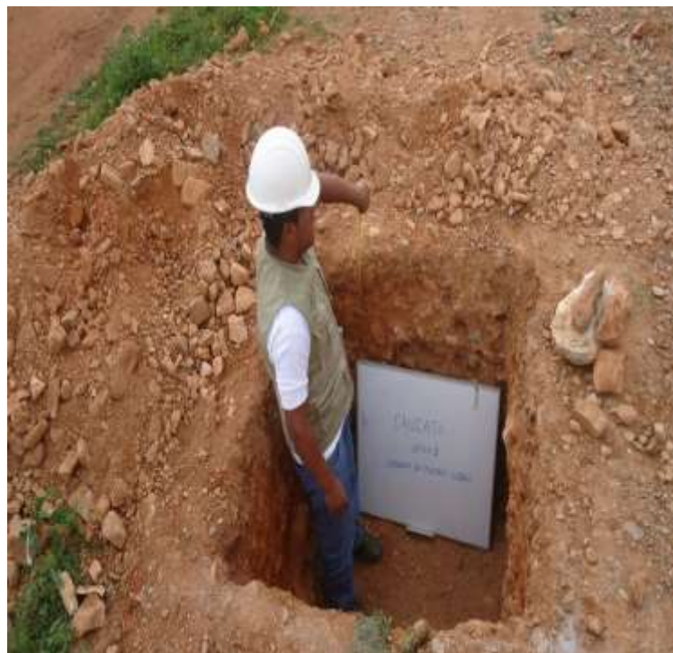
Foto N° 02: Excavación de la Calicata N° 01
