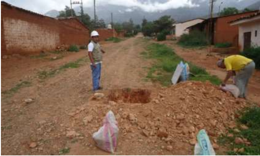
Foto N° 07: Excavación de la calicata N°02
