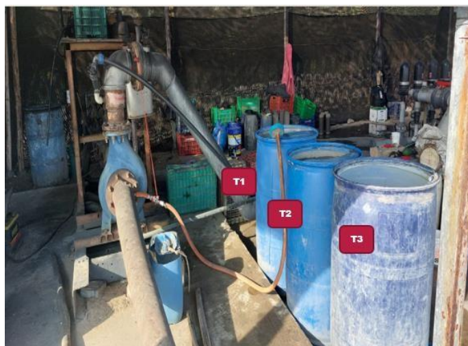
Figura 5. Etapa de inyección al sistema de riego
