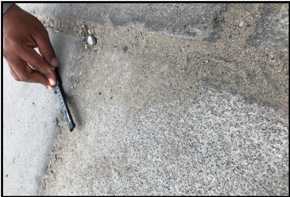
Figura 17: midiendo la junta en diagonal.
