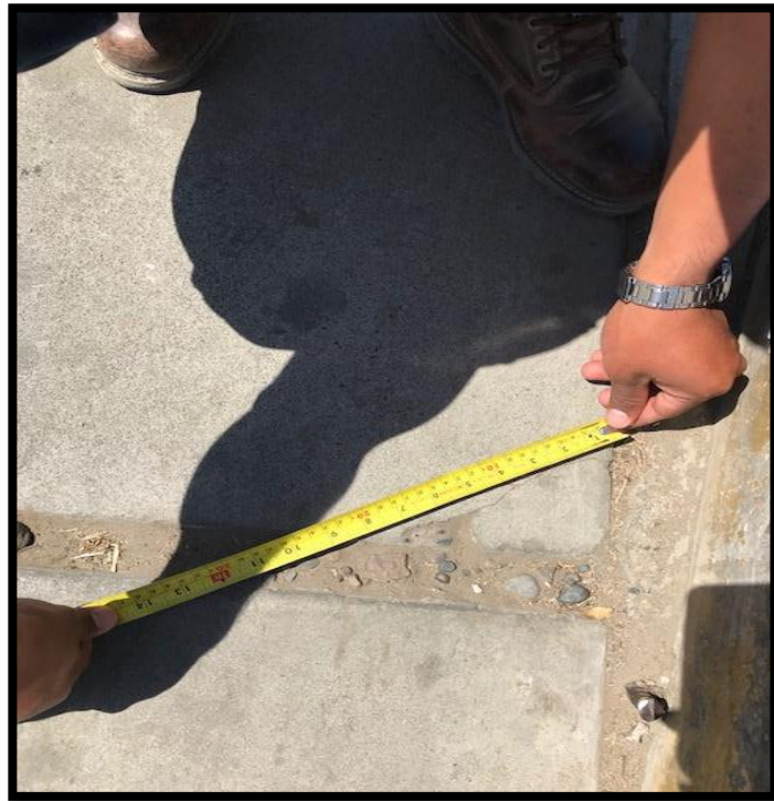
Figura 8: Midiendo la junta con wincha de pavimento.
