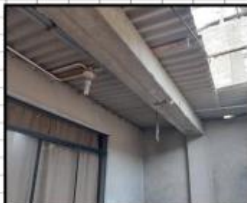
SE VACIO SOLO LA MITAD DE LA VIGA Y NO EN SU TOTALIDAD A LA VEZ
