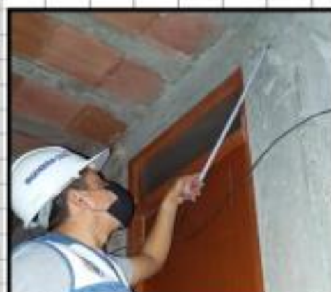
CANGREJERAS EN LA UNION COLUMNA - VIGA
