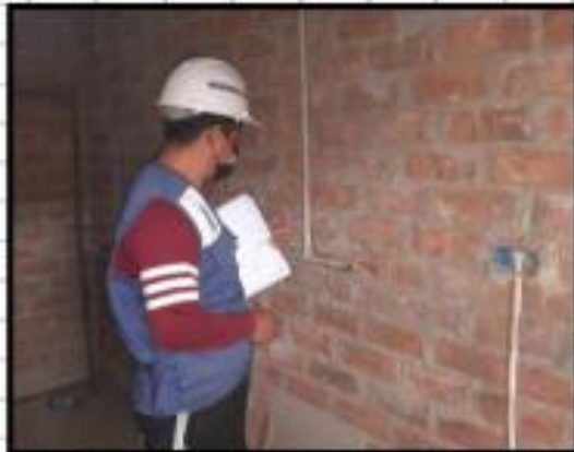
COLOCACION DE LAS TUBERIAS PARA LAS INSTALACIONES ELECTRICAS
