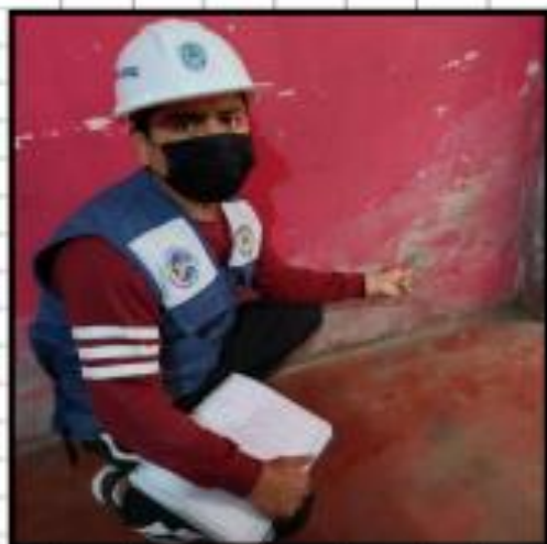
SALITRE EN LOS MUROS PRODUCTO DE LA HUMEDAD
