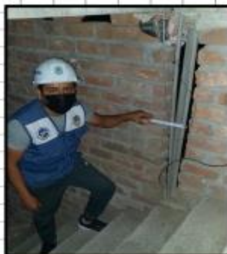
SE CORTO EL MURO (13CM) PARA EL PASO DE LOS TUBOS DE AGUA
