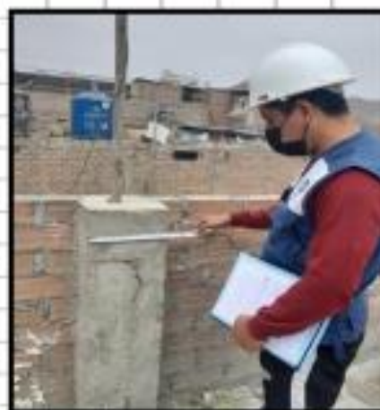
DIMENSION DE LAS COLUMNAS DE LA VIVIENDA ES DE 0.30 X 0.25
