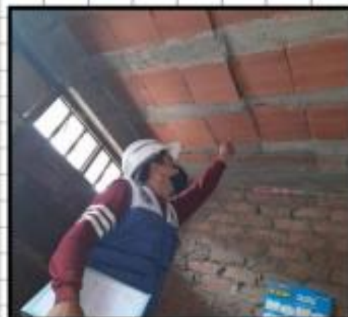
REGULAR PROCESO CONSTRUCTIVO EN LA LOSA ALIGERAD - LADRILLOS QUE
