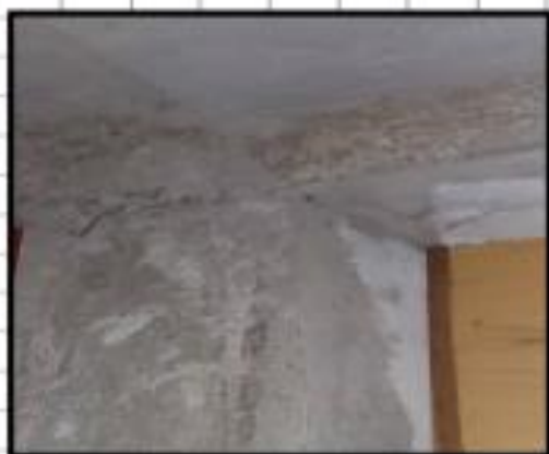
UNION DE VIGA CON COLUMNA EN BUENAS CONDICIONES
