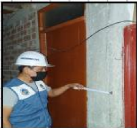
COLUMNAS CON DIMENSIONES DE 0.30 X 0.30 M.
