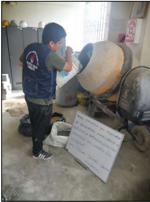
Foto 13 Elaboración de la mezcla del concreto
