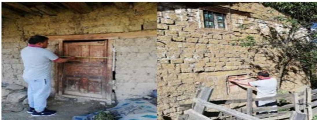
Figura 6. Toma de medidas del vano de la puerta y toma de medida del vano de la ventana.
