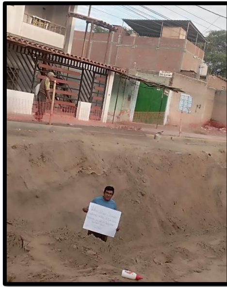
Figura 36. Vista panorámica de la zona de excavación
