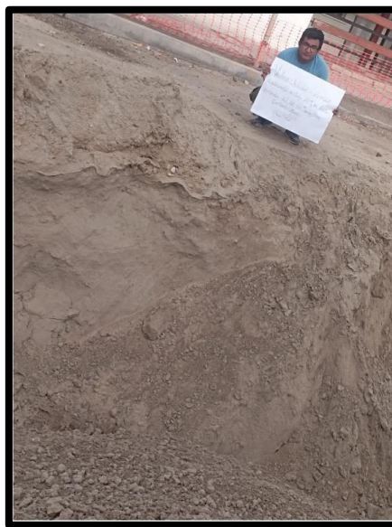
Figura 35. Realizamos la excavación
