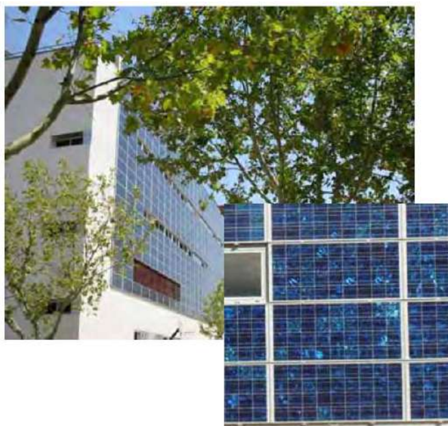
Figura 97. Instalación de fachada ventilada. Recuperado de: http://www.madrid.org/bvirtual/BVCM005913.pdf
