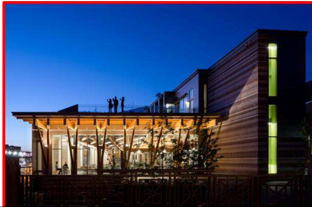
Figura 89. Fachada Oeste de la Escuela. Recuperado de: http://www.aiatopten.org/node/336
