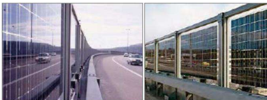
Figura 102. Muros de protección contra el ruido fotovoltaico. Recuperado de: http://rua.ua.es/dspace/handle/10045/44245
