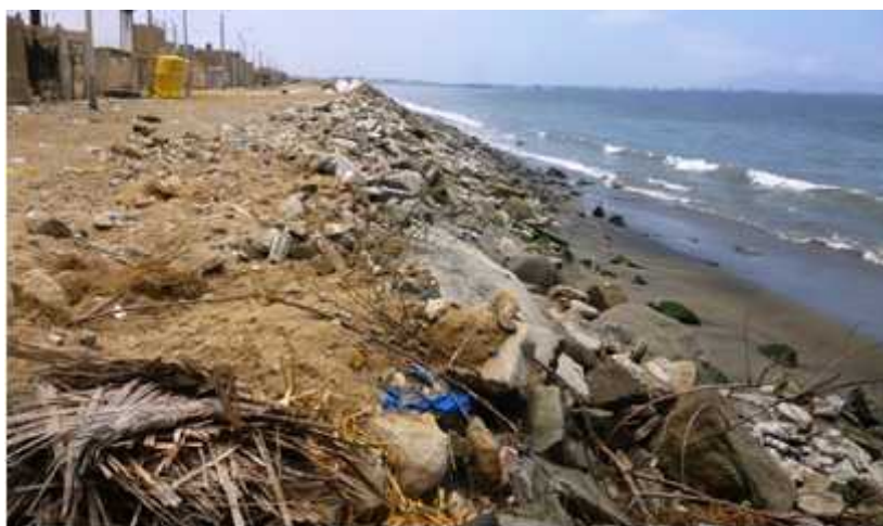
Figura 8: Estado Actual de Defensa Costera Precaria
