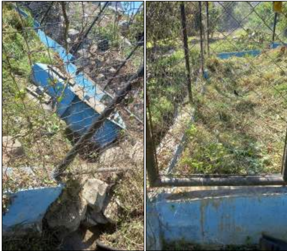
Fotografía 10. Fotografía de la realidad del muro de malla olímpica. Fuente: Propia.
