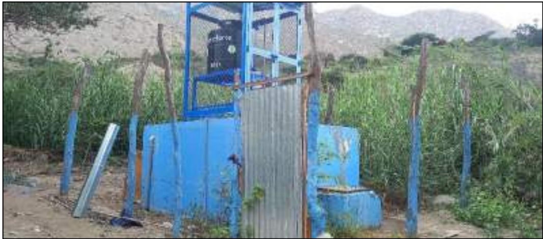
Fotografía 1. Clave de la estructura. Fuente: Propia.
