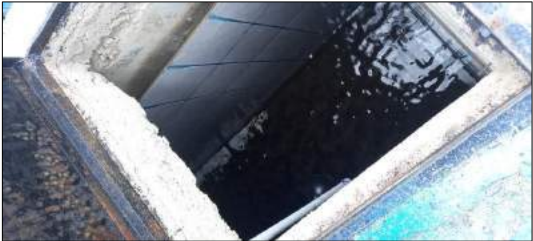
Fotografía 4. Fotografía del interior del Reservorio. Fuente: Propia.
