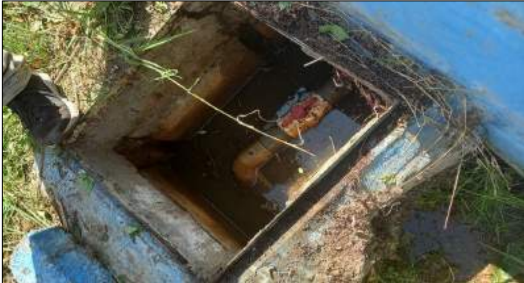
Fotografía 15. Interior de la Cámara Seca en estado inundado. Fuente: Propia.
