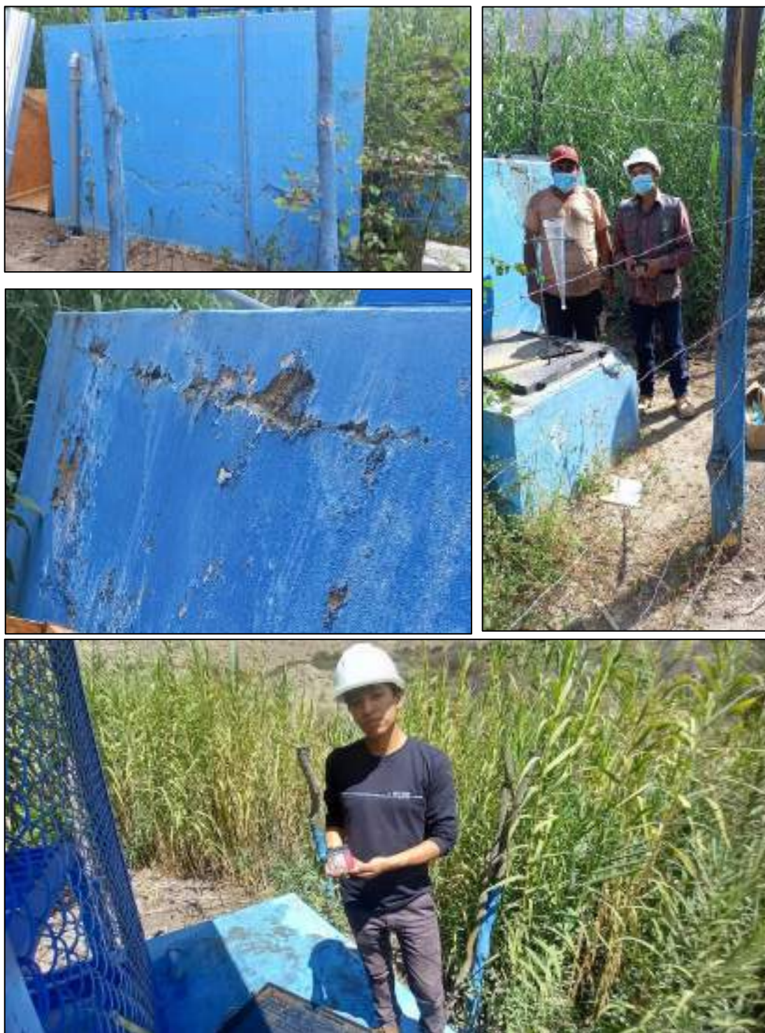
Fotografía 24. Tomas del Reservorio Existente de CC.PP. Huichay. Fuente y Elaboración: Propia
