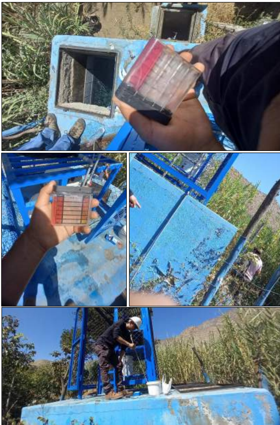
Fotografía 25. Tomas del Reservorio Existente de CC.PP. Huichay. Fuente y Elaboración: Propia
