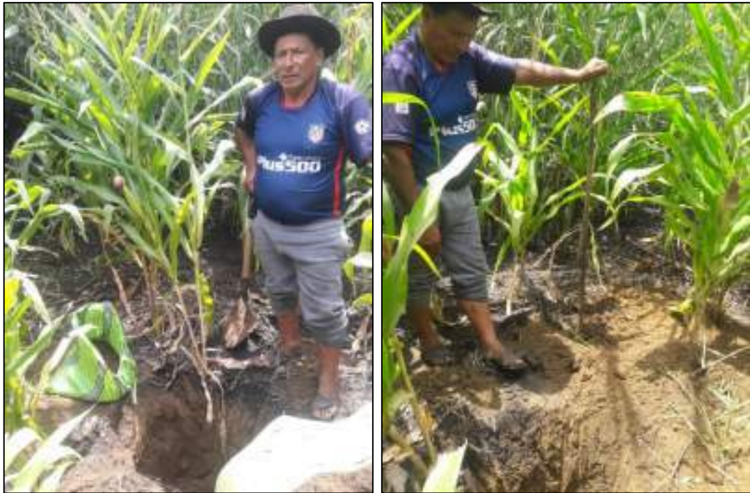
Fotografía 17. Calicata en la captación existente. Fuente y Elaboración: Propia.
