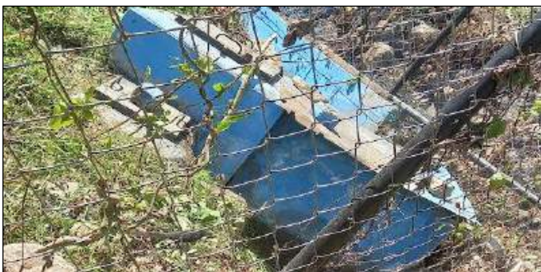
Fotografía 13. Detalle del Cerco Perimétrico. Fuente: Propia.
