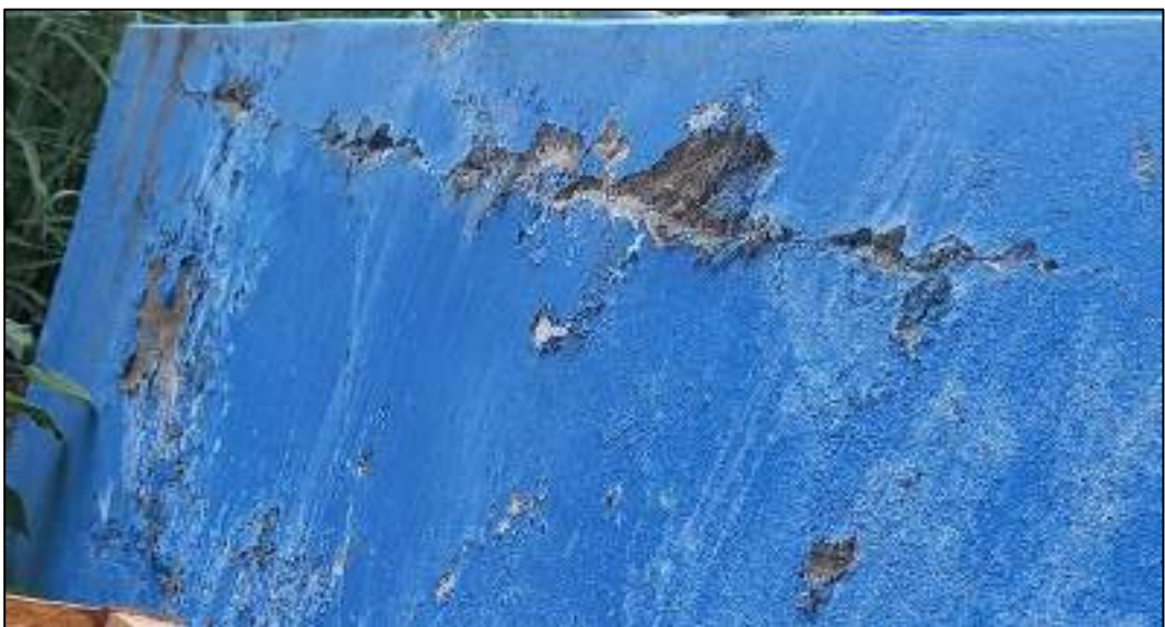
Fotografía 3. Paredes del Reservorio Fuente: Propia.
