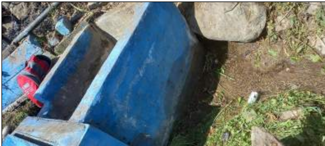
Fotografía 12. Muros de los Aleros. Fuente: Propia.
