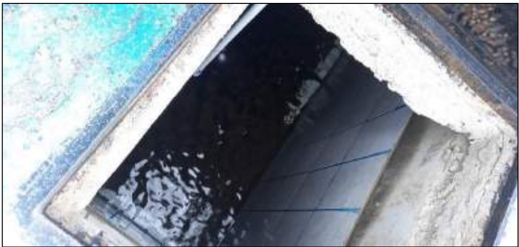
Fotografía 5. Interior del reservorio. Fuente: Propia.
