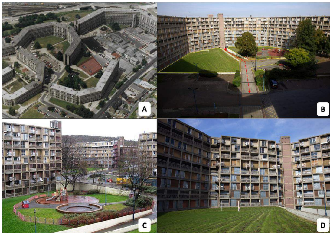
Figura 20: Vista de espacios exteriores del edificio Park Hill.
