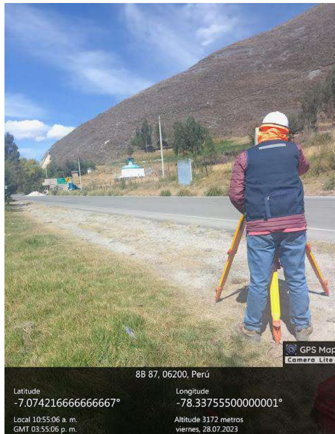
Fotos N° 01 y N°2. Se aprecia sacando puntos para medir el ancho del carril.
