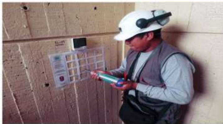
Figura 5. Aplicación del ensayo de esclerometría
