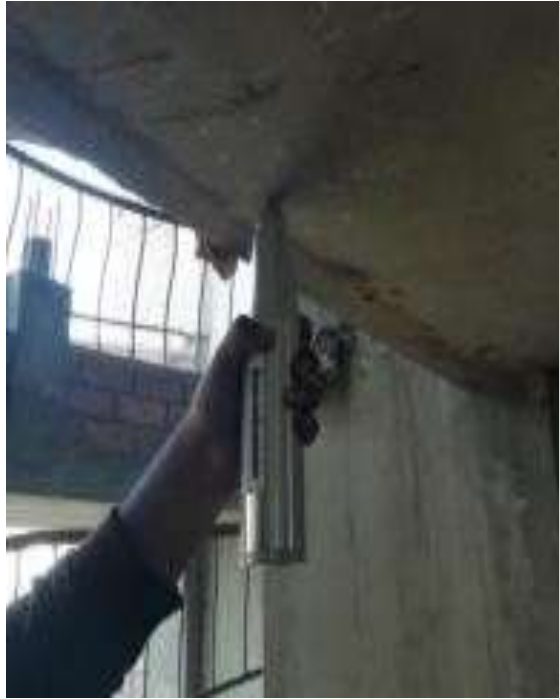
Foto 8: Esclerometría en vivienda del P.J. Miramar Bajo
