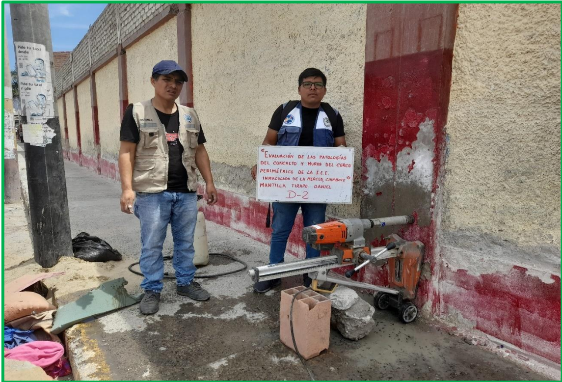
Perforación de la columna del muro perimetral 2 con una perforadora diamantina
