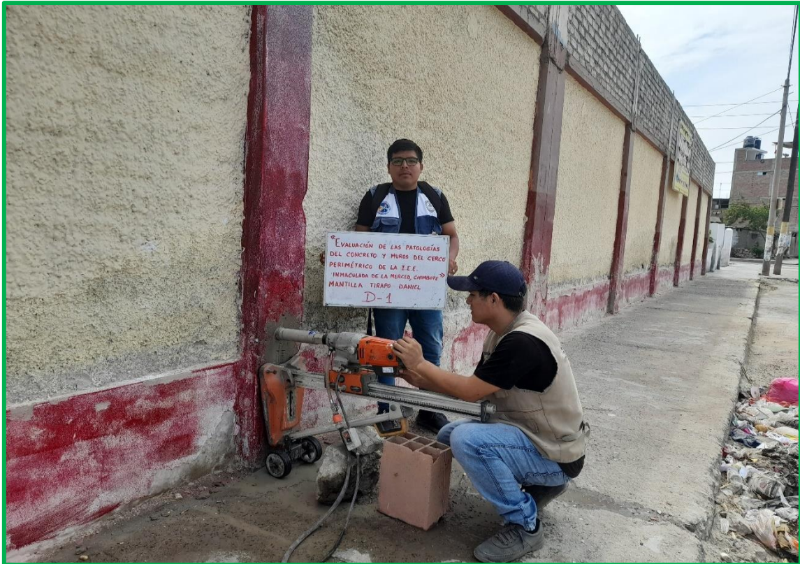
Perforación de la columna del muro perimetral 1 con una perforadora diamantina
