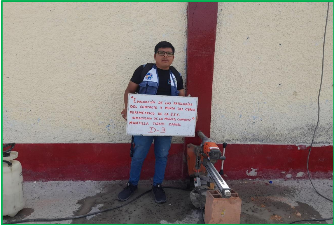
Perforación de la columna del muro perimetral 3 con una perforadora diamantina
