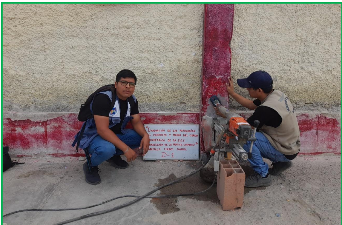
Colocación del detector de metales en la columna del muro perimetral 1 antes de realizar la perforación
