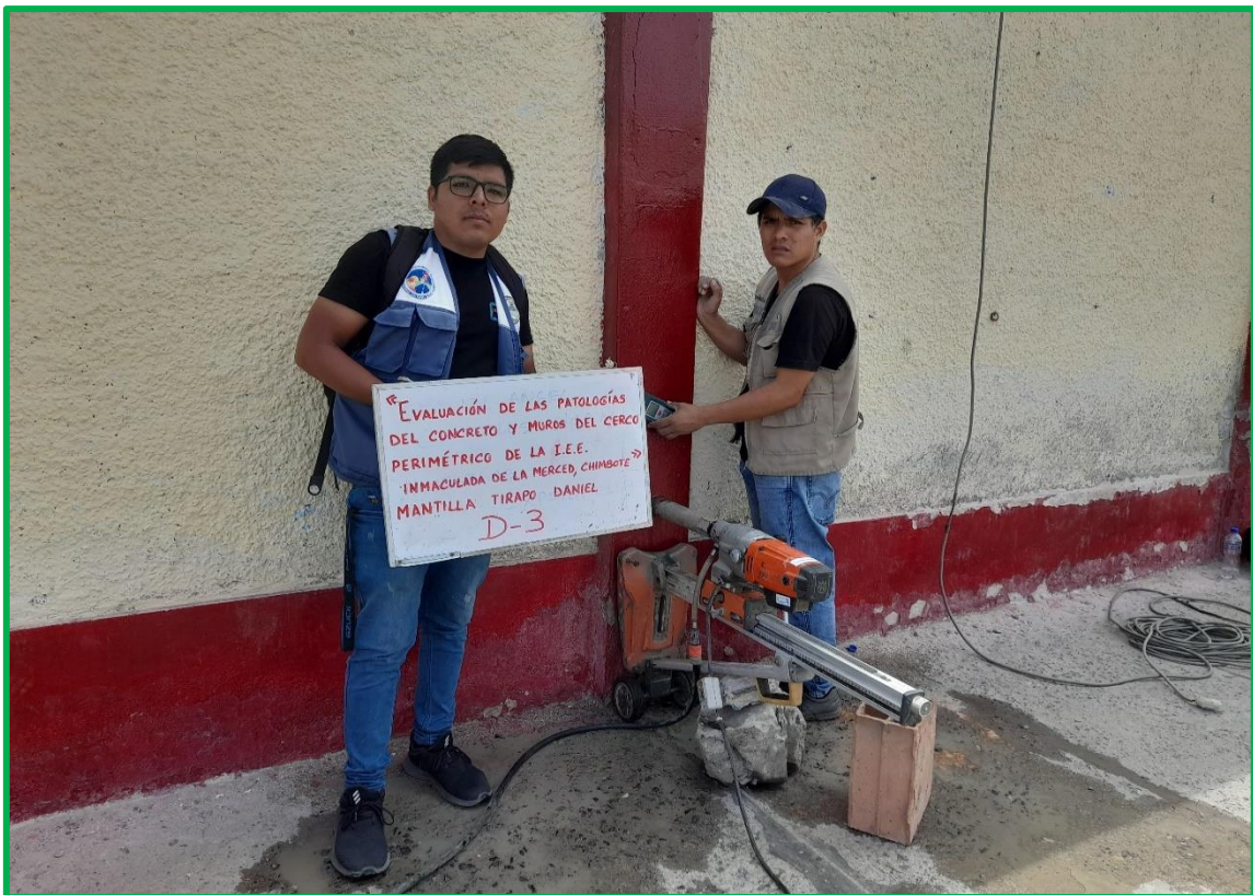
Colocación del detector de metales en la columna del muro perimetral 3 antes de realizar la perforación
