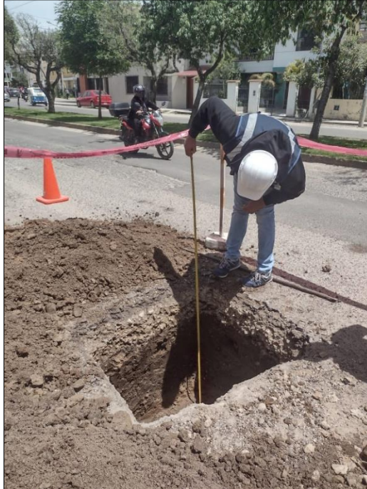
Fotografía 3 1,50 m de profundidad Calicata – 3 para ensayos de suelos. Av Mario Urteaga, sentido SE - NO
