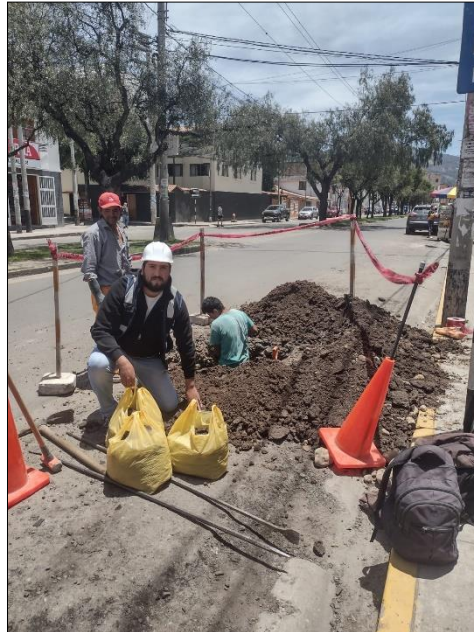
Fotografía 1 Recolección de muestras para ensayos de suelos en laboratorio C-1. Av. Mario Urteaga, sentido SE - NO.
