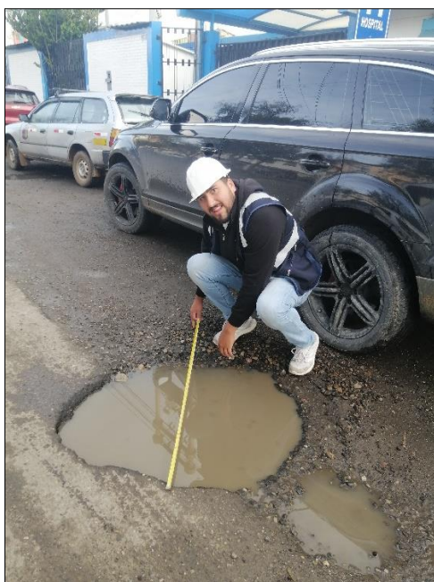
Fotografía 14 Medición de patología hueco, severidad alta. Av. Mario Urteaga, sentido SE – NO.
