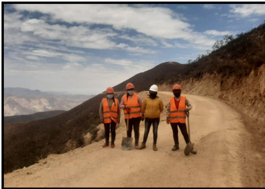
FOTO N.º 03: En la fotografía se observa el proceso la calzada limpia y la cuadrilla completa
