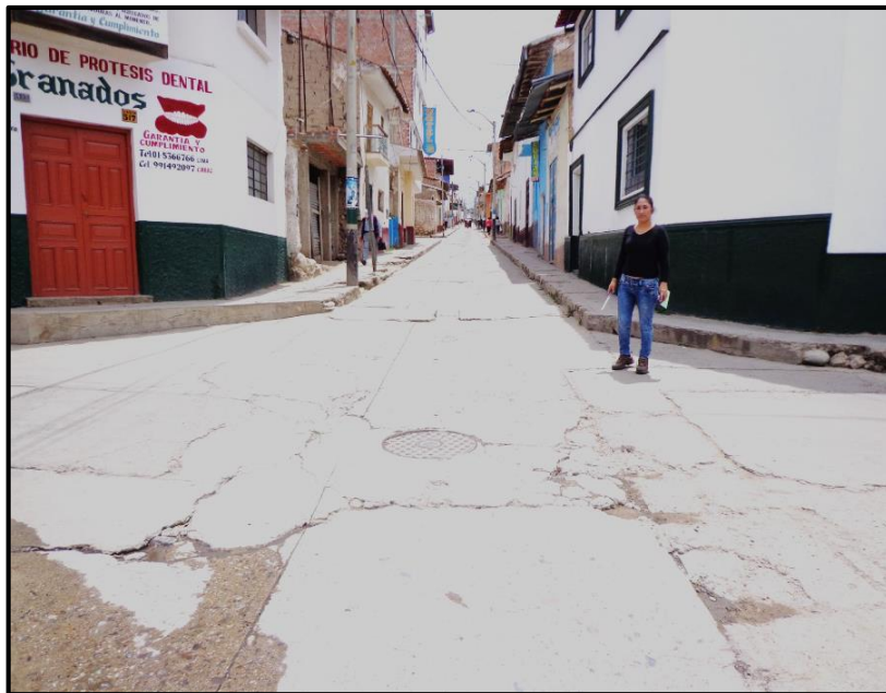
Figura 03: estructura del Jr. San Martín
