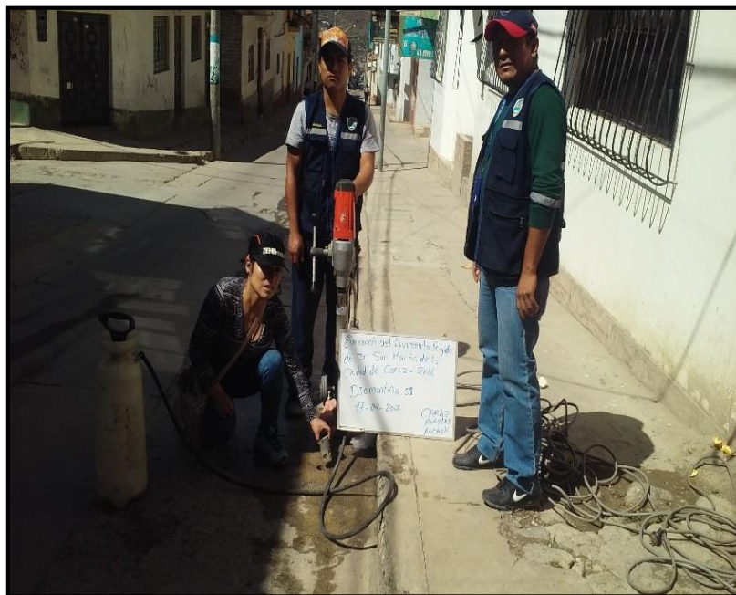
Figura 04: Realizando el ensayo de diamantina
