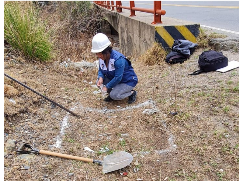
Fotografía 02: Se observa el trazado de la calicata, para la excavación.
