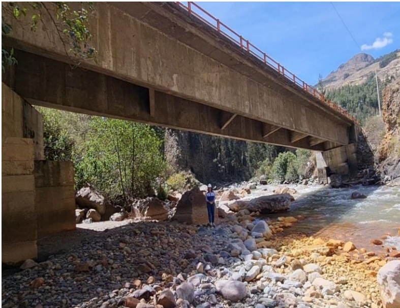
Fotografía 01: Vista fotográfica del puente Bedoya.
