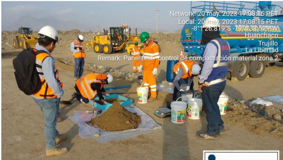
Ensayo de control de compactación con método de remplazo de agua.
