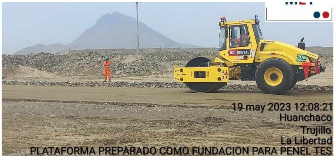
Conformación De Terreno De Fundación.
