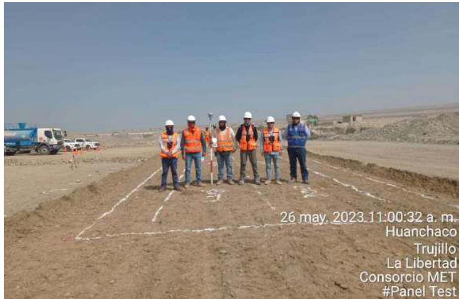
Verificación de trazo de los 8 puntos de control en el material suelto h=0.65m imagen.
