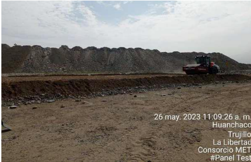
Relleno de capa de 0.65 de material zona 2.
