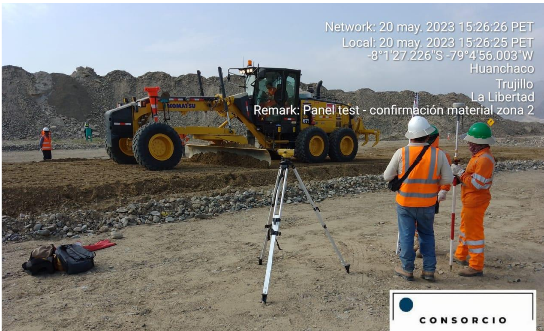
Nivelación de espesor de capa 0.35 m.
