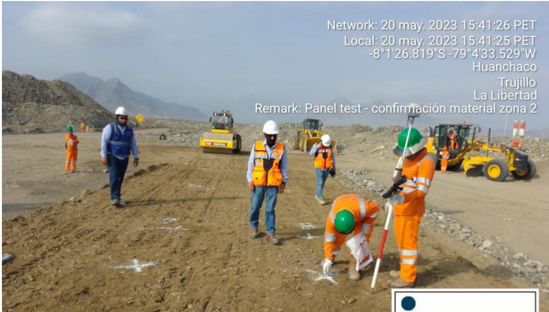
Plantillado y Verificación de Espesor de Capa.
