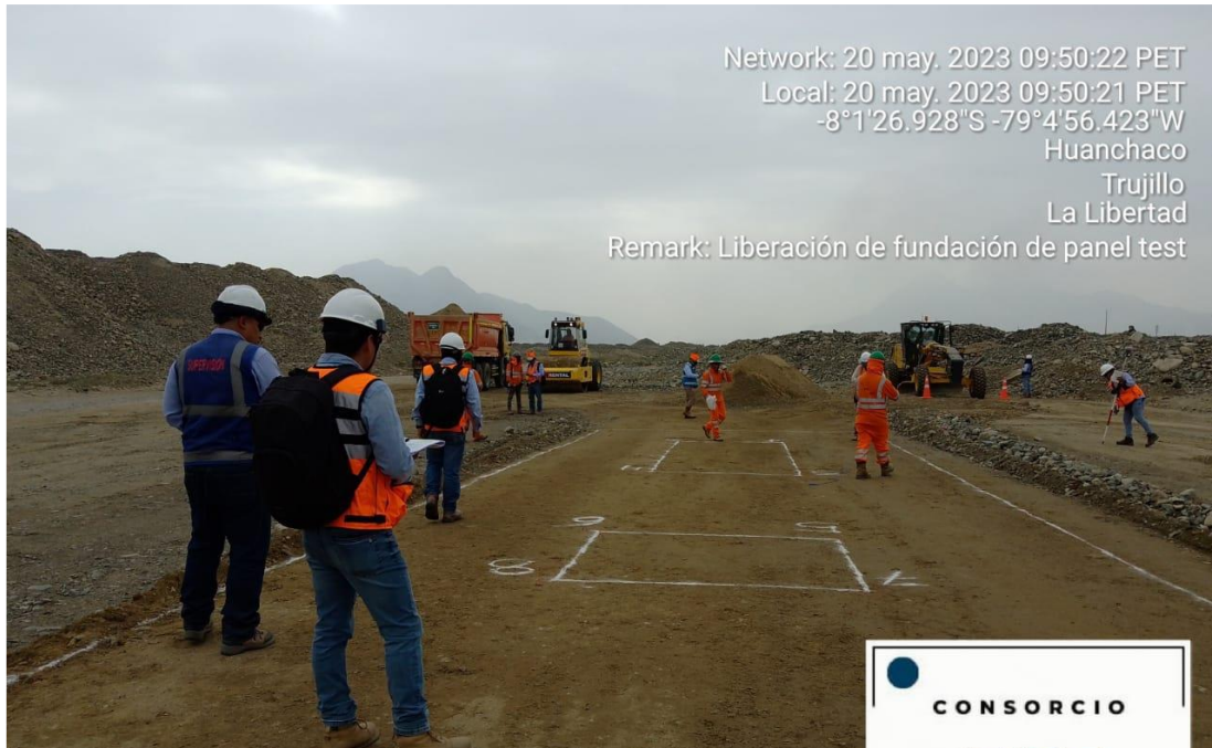
Verificación De Nivelación En Terreno De Fundación.
