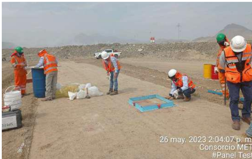
Ensayo de control de compactación con método de remplazo de agua
