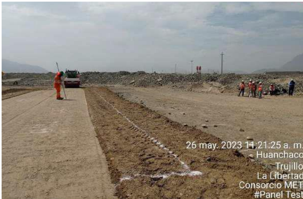
Plantillado y verificación de espesor de capa e=0.65 material suelto, e=0.60 compactado.
