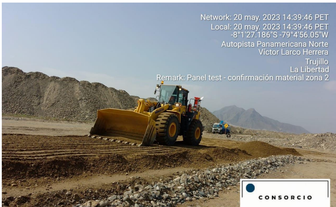
Relleno de Capa de 0.35 de Material Zona 2.
