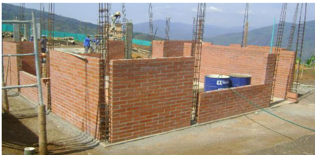
Fig. N°1: Detalle de muro de albañilería confinada
