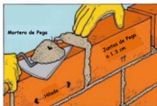
Figura 16: Calidad de las Juntas de Pega en Mortero
