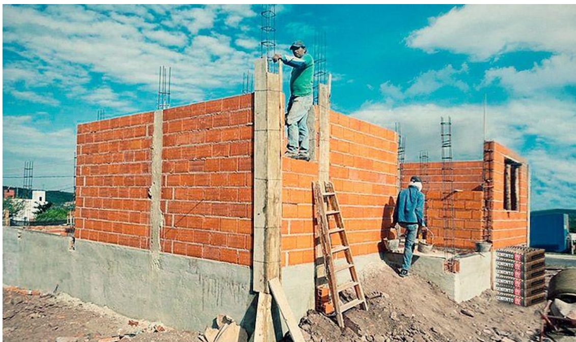
Fig. 02: Vivienda Construida con Albañilería Confinada
