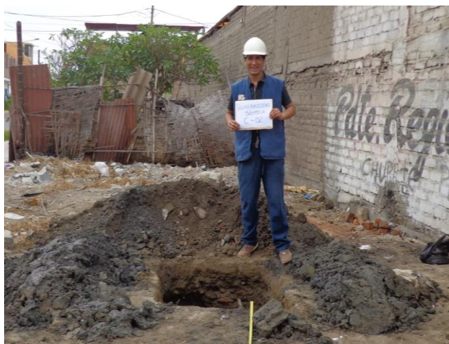
FOTO N° 1: Calicata realizada en vivienda localizada en Jr. Fátima Mz I2 – Lt 27
