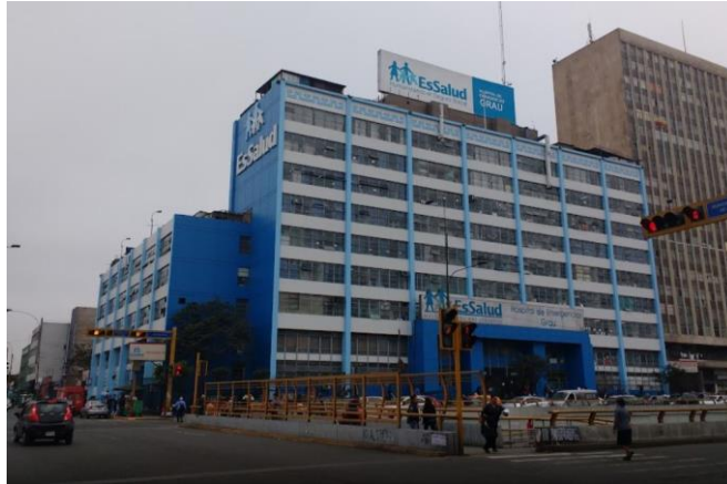
Figura 8. Vulnerabilidad no estructural (EsSalud, 2021)
