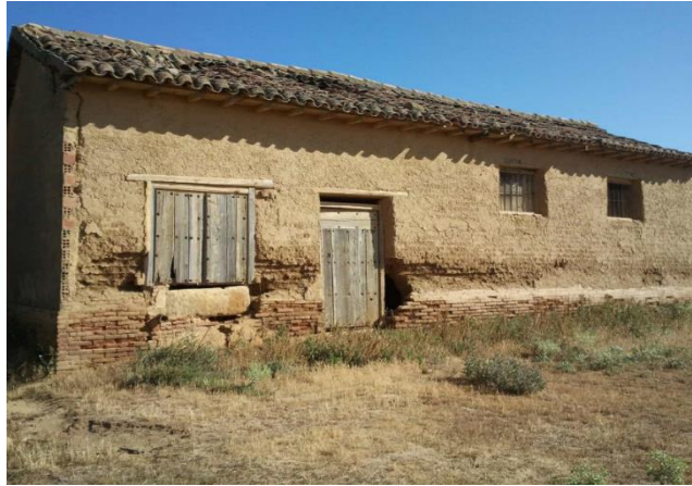
Figura 6. Vivienda Tipo Mampostería no reforzada.
